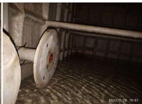
Para el día sábado se realizará los refuerzos a la estructura y a los puntos que generan filtraciones. al igual se hará el cambio de tubería, que actualmente es de acero-carbono a polipropileno, para así, mitigar la oxidación que se genera con el contacto con el agua , adicional el dia domingo en horas de la noche se realizará el lavado y desinfección del tanque para que el día lunes ya esté operando con normalidad.
