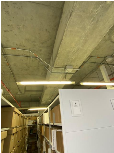
En varias vigas del entrepiso del quinto piso (y en otros pisos y sótanos) se encontraron pequeñas grietas menores a 0.5 mm de espesor (daño LEVE), ubicadas cerca al centro de la luz de las vigas. Estas grietas se producen por pequeñas deflexiones de las vigas en el centro de la luz debidas a las cargas de servicio que actúan sobre ellas. Cuando estas grietas por flexión empiezan a tener un espesor mayor a 1.0 mm (daño MODERADO) es probable que se requiera una revisión estructural analítica y posiblemente una intervención de reforzamiento.
