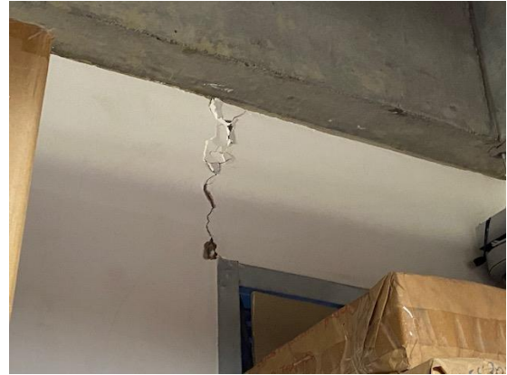
Foto izq. Grieta leve en uno de los muros del quinto piso con tamaño menor a 1.0 mm. Foto der. Agrietamiento vertical en la mampostería, que se genera en la esquina del marco de la puerta, por cambio de rigidez del muro a causa del vano de la puerta.
