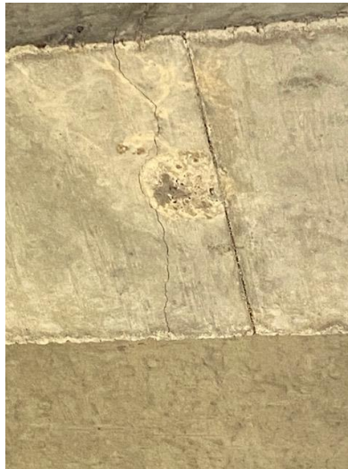
En varias vigas del entrepiso del quinto piso (y en otros pisos y sótanos) se encontraron pequeñas grietas menores a 0.5 mm de espesor (daño LEVE), ubicadas cerca al centro de la luz de las vigas. Estas grietas se producen por pequeñas deflexiones de las vigas en el centro de la luz debidas a las cargas de servicio que actúan sobre ellas. Cuando estas grietas por flexión empiezan a tener un espesor mayor a 1.0 mm (daño MODERADO) es probable que se requiera una revisión estructural analítica y posiblemente una intervención de reforzamiento.
