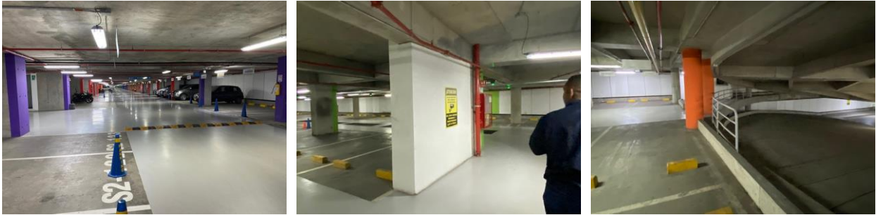
Durante la inspección visual del sótano 2 no se encontró ningún daño estructural.
