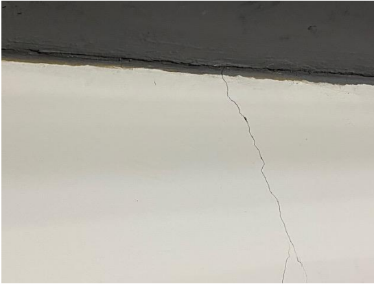
Foto izq. Grieta leve en uno de los muros del quinto piso con tamaño menor a 1.0 mm. Foto der. Agrietamiento vertical en la mampostería, que se genera en la esquina del marco de la puerta, por cambio de rigidez del muro a causa del vano de la puerta.
