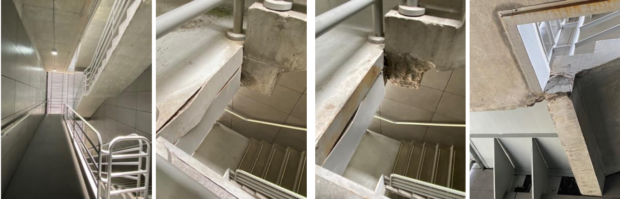
A pesar del golpeteo entre las torres 2 y 3 las vigas que soportan la escalera se encuentran en buen estado estructural.
