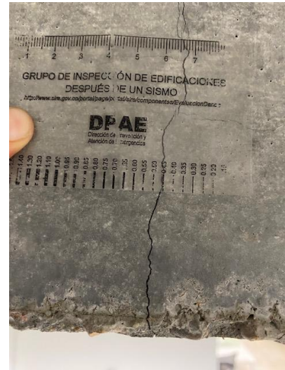
En varias vigas del entrepiso del quinto piso (y en otros pisos y sótanos) se encontraron pequeñas grietas menores a 0.5 mm de espesor (daño LEVE), ubicadas cerca al centro de la luz de las vigas. Estas grietas se producen por pequeñas deflexiones de las vigas en el centro de la luz debidas a las cargas de servicio que actúan sobre ellas. Cuando estas grietas por flexión empiezan a tener un espesor mayor a 1.0 mm (daño MODERADO) es probable que se requiera una revisión estructural analítica y posiblemente una intervención de reforzamiento.
