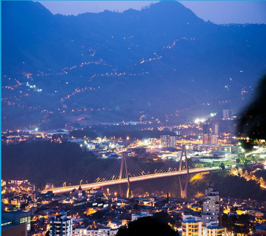
Viaducto Cesar Gaviria Trujillo foto por Norbey en Wikipedia
